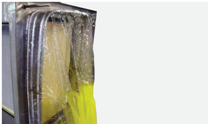
Fig. 4 : Notez que la sangle élastique du sac est placée à l'intérieur de la deuxième nervure
