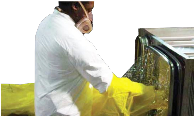
Fig. 9 : Le sac repose sur une surface plane parallèle et non sur le sol
